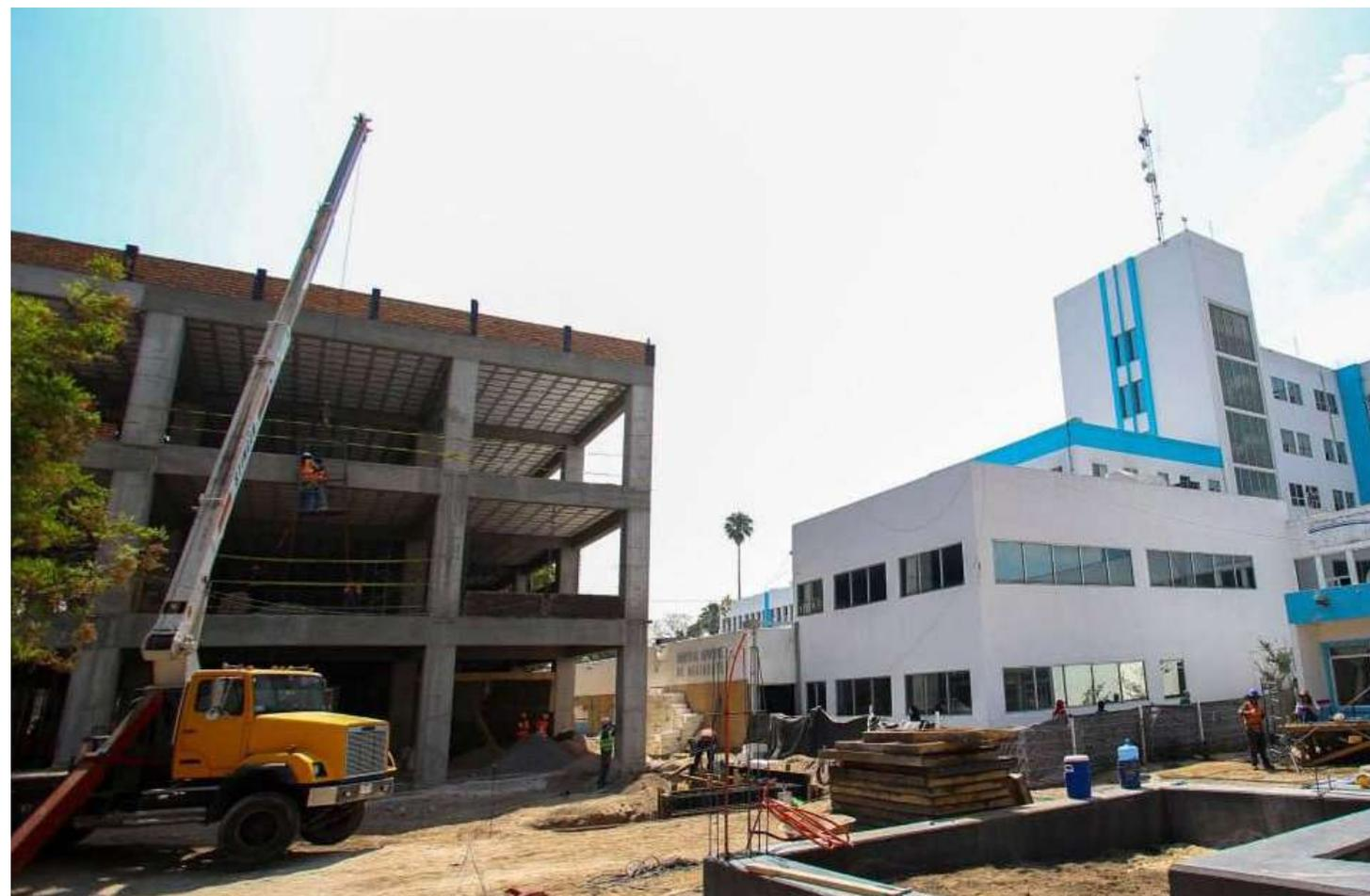
almacén general. Este último fue demolido debido a que se encontraba obsoleto y no cumplía con las normas vigentes. En su lugar, se está construyendo un nuevo edificio que se encuentra en la etapa de estructura metálica y albañilería, y se espera que los acabados estén finalizados en la primera semana de julio.
